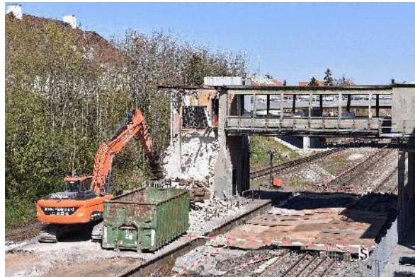
Vo med den gamle gangbro under nedrivning.
